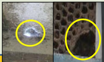
壁や金網の破損修繕
